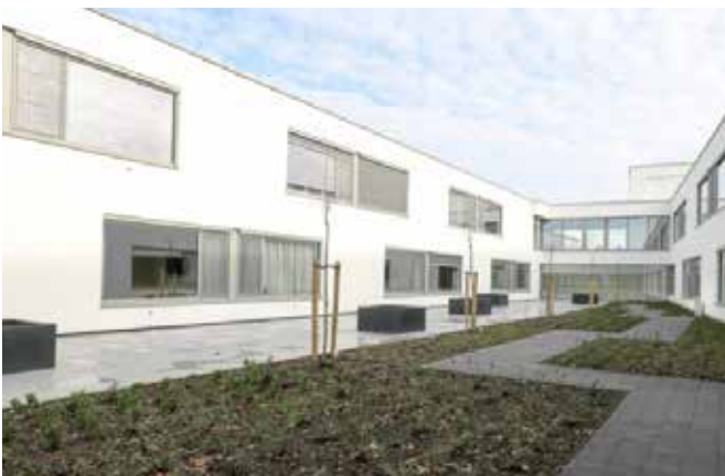
WZC Vinkenbosch - Belgium - Strada & Oxygen
